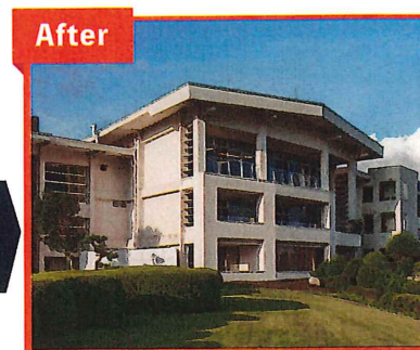
耐震改修完了
