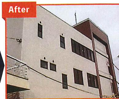
コンクリート剥落 鉄筋爆裂 施工後
