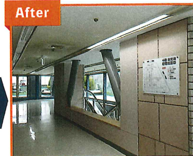
耐震改修完了
