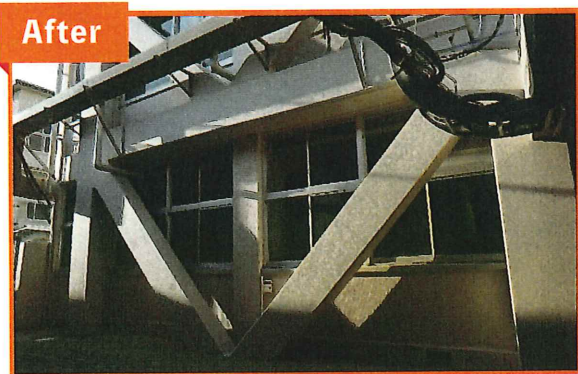
耐震改修完了
