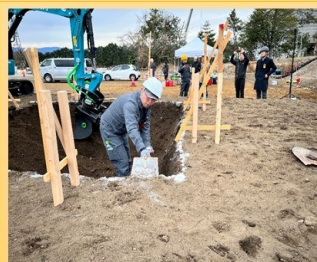
端部はスコップを用いて人力作業
