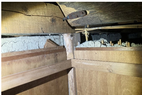
(仕口の金物の有無、金物の種類、緊結及び劣化状況の確認)
