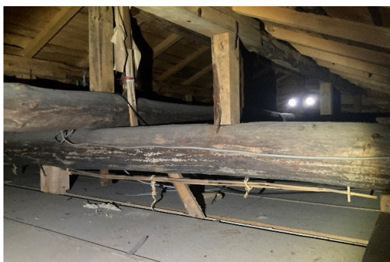
(母屋・野地板・梁等の確認)
