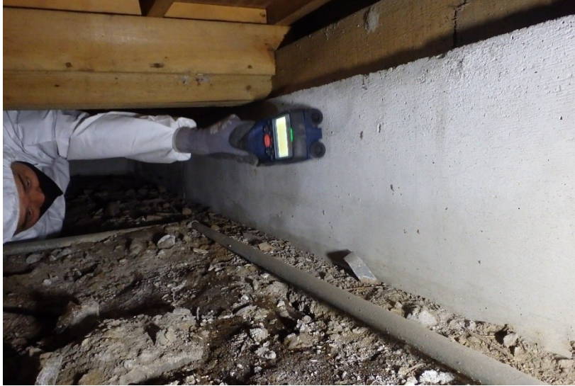
(床下点検口からの調査の様子)
