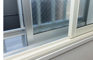
全住戸の内窓設置を実施
