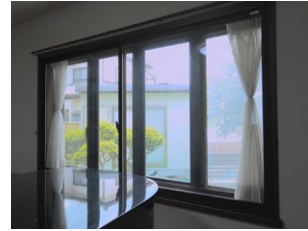
内窓設置を実施
