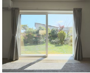
外窓交換(はつり工法)を実施
